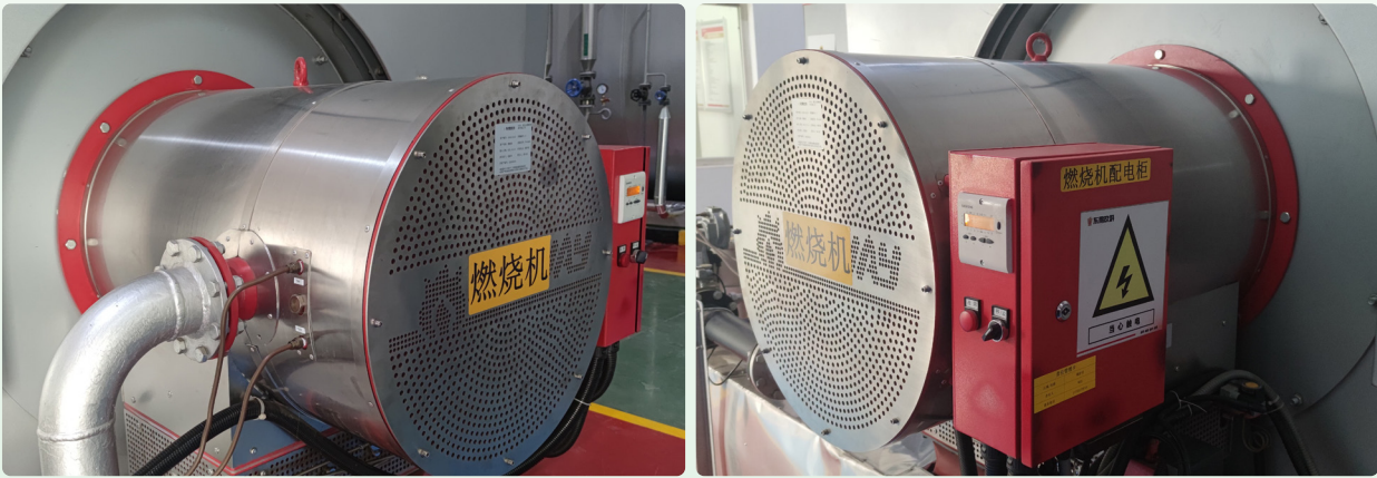
锅炉燃烧机低氮改造
